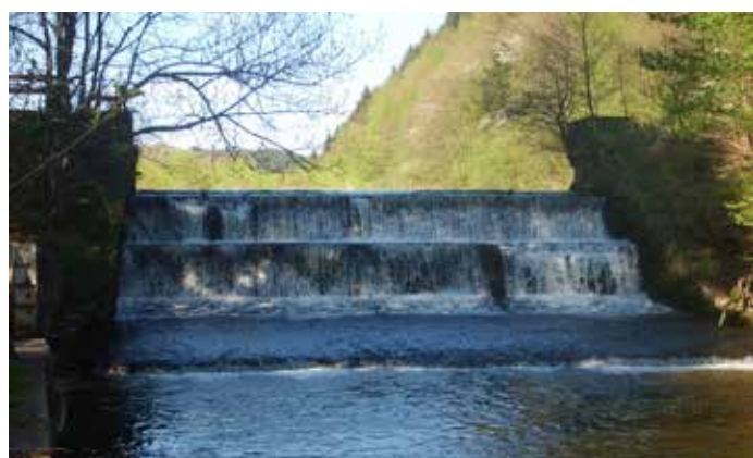
Barrage de Bévercé - Staudamm Bévercé
