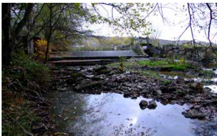
Seuil d'alimentation du moulin Mayeres Staudamm Mayereser Mühle
