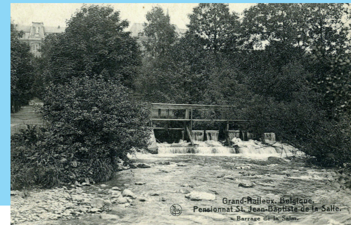
Barrage de la Salm (lire Le Glain) : Ce barrage déviait une part importante du débit vers la turbine par un chenal non couvert.
