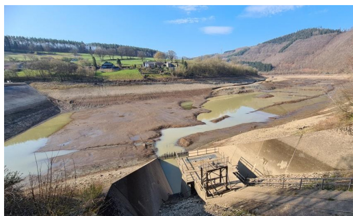
Photo après la vidange de Coo, au niveau du barrage aval.
