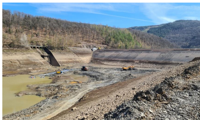
Photo au commencement des travaux.
