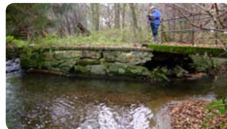
Protection des berges / Ouvrage
